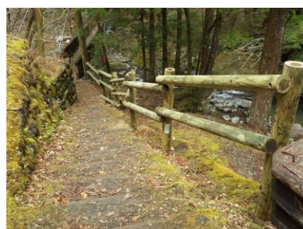
整備した遊歩道
