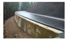
間伐材を谷止工背面部で撤去が不要な残置式の型枠として利用した。 また、前面についても、付近の景観に配慮し、間伐材による残置式型枠を利用 した。間伐材を54 m³ 使用。(米代西部森林管理署:秋田県)
