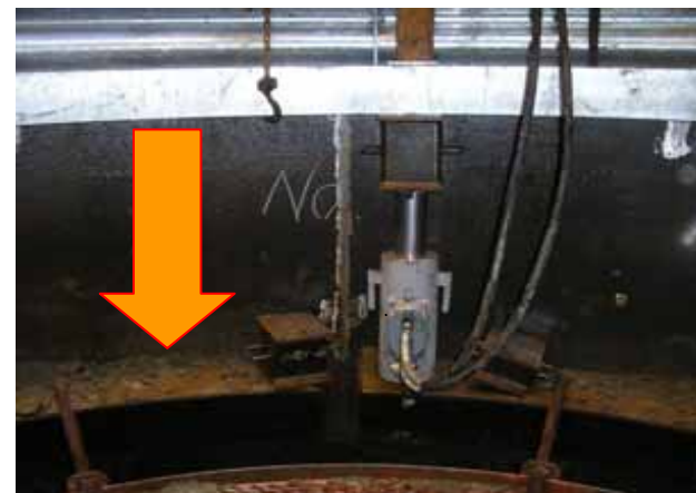
油圧ジャッキによる沈下
