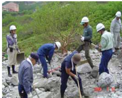
除去作業の状況
