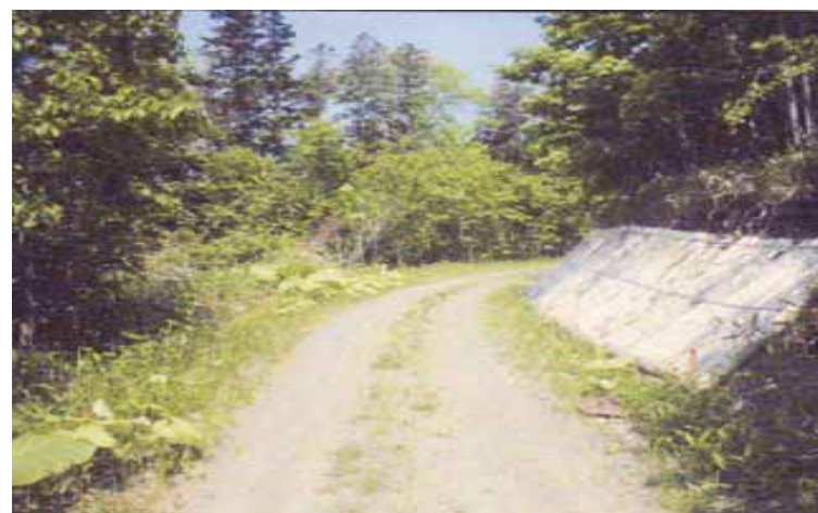
法面に丸太伏工を設置した状況
