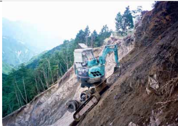
高所法面掘削機(RCM)による法切工
