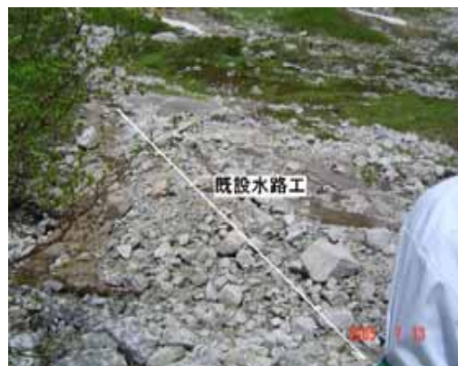
埋没した水路と堆積した土砂 (土砂が植物に覆い被さっていた)
