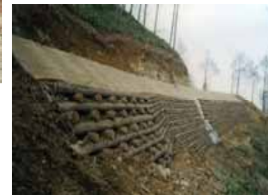
木製ブロック積工
