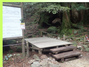
完成した木製デッキ
