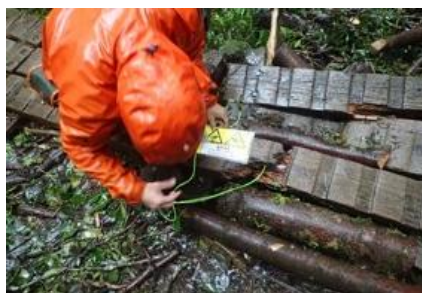
注意標識の設置
