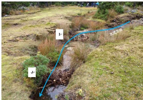
堰 H, I 設置直後 (2024/11/20 撮影)
