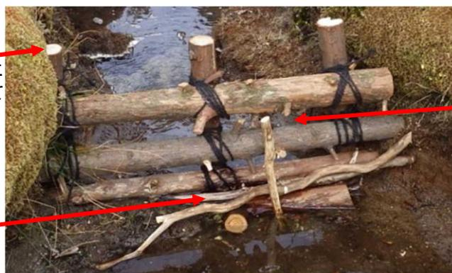
側壁浸食を軽減するため、横方向丸太は3cm程度の隙間を設けた。
