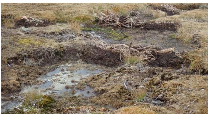
作業の様子（上）と敷き詰めた枝条等（下）
