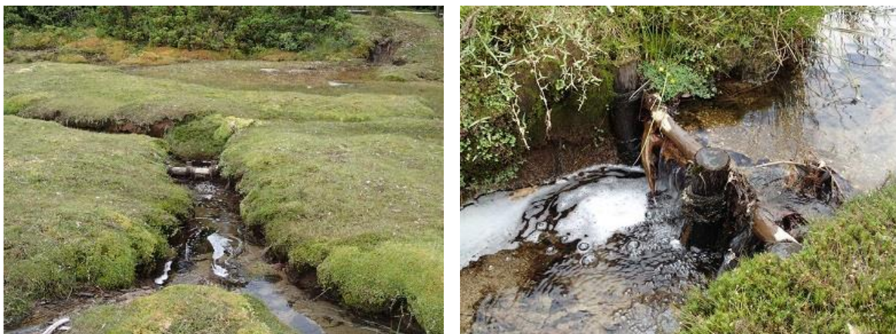
丸太木柵工の設置と堆砂の状況
