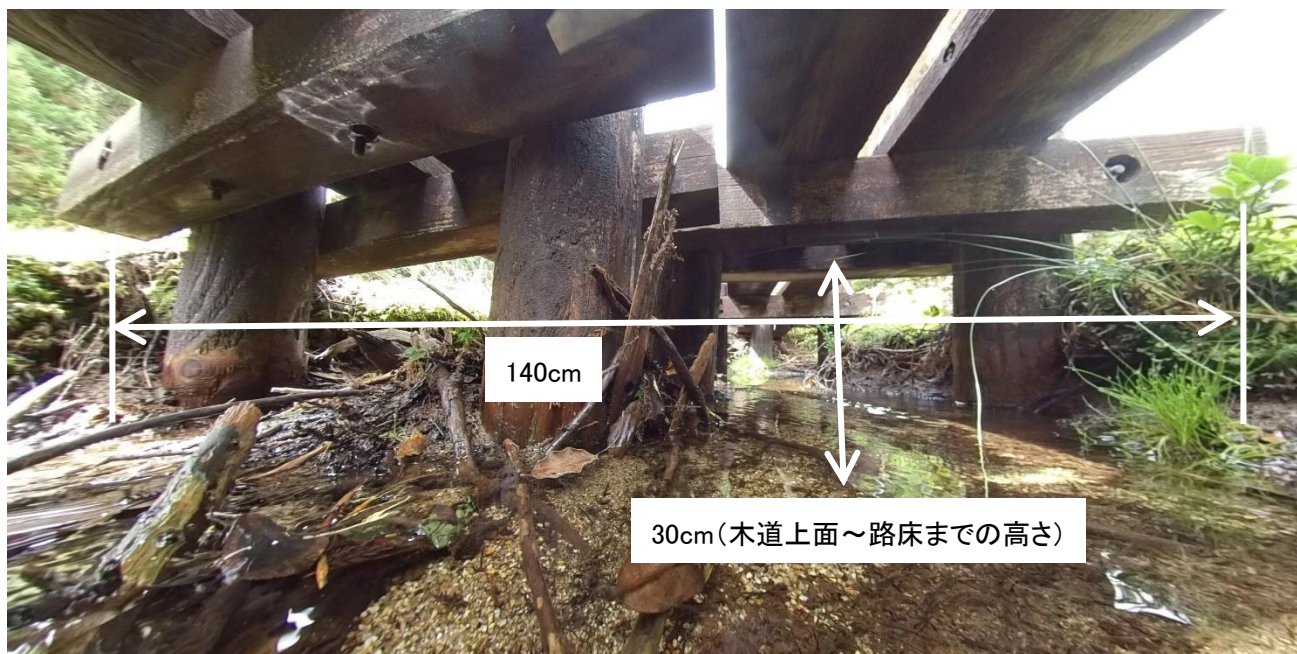
堰の設置箇所(案) 橋桁下から撮影
