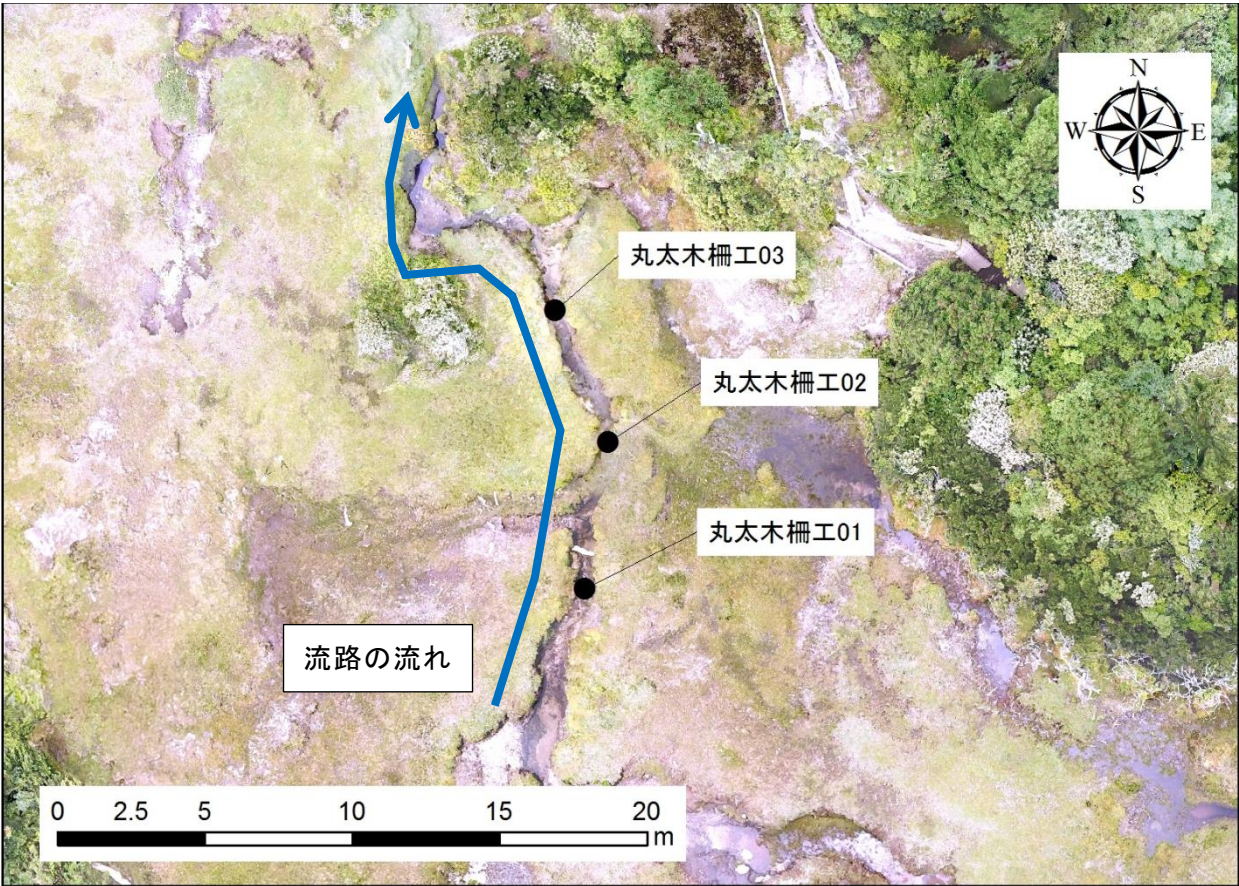
図 1-1 試行的保全対策（丸太木柵工）の設置箇所
