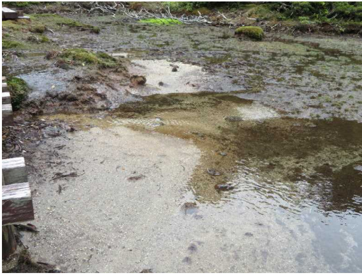
歩道からマサ土の流入状況 (地層が堅くなっている)
