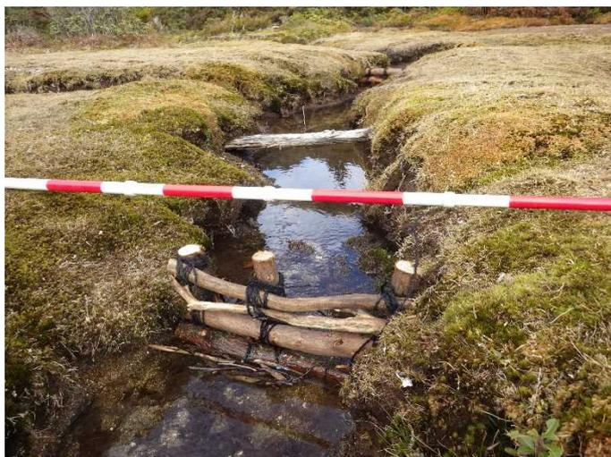
写真 2-4 丸太木柵工 01(流路断面、横 65cm × 縦 32cm)
