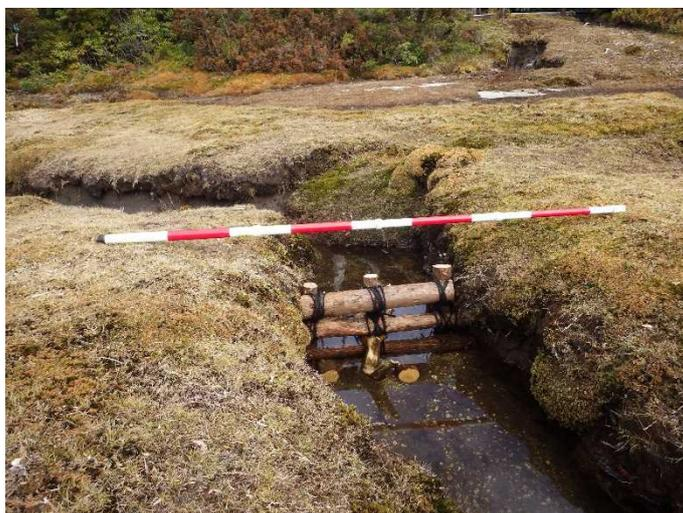
写真 2-5 丸太木柵工 02(流路断面、横 68cm × 縦 42cm)
