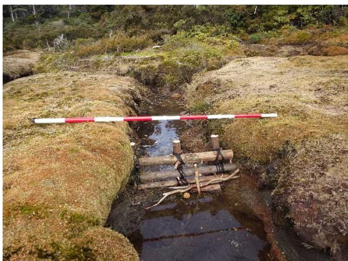
写真 2-6 丸太木柵工 03(流路断面、横 91cm × 縦 52cm)
