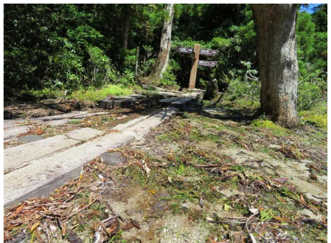
⑫歩道からの土砂の流入状況
