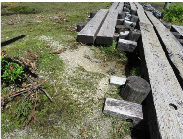
⑪歩道からの土砂の流入状況
