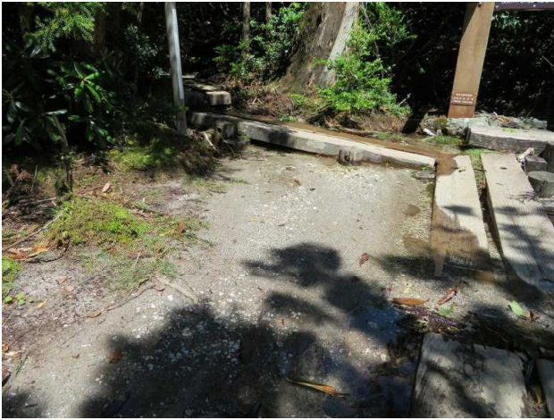
⑬歩道からの土砂の流入状況
