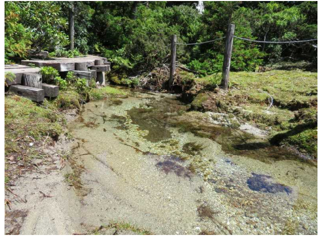
⑭流路からの土砂の流入状況
