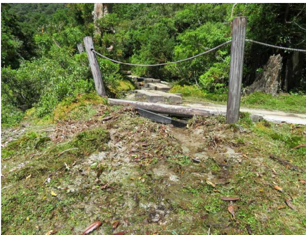
⑮歩道からの土砂の流入状況
