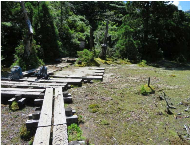
⑨歩道の奥から歩道入り口をみる 流入土砂が堆積している
