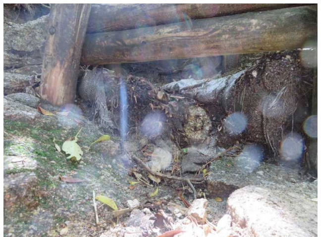
⑥ 土のうに詰めた土砂が破れて流れ出ている
