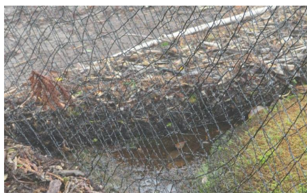
図 2 植生保護柵による土留め設置イメージ
