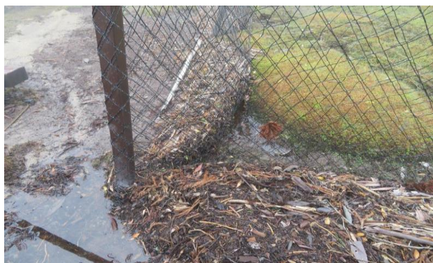
図 2 植生保護柵による土留め設置イメージ
