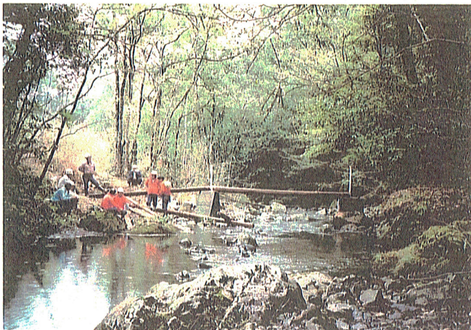
橋脚の上に丸太を乗せる (上流から) H15.3.24
