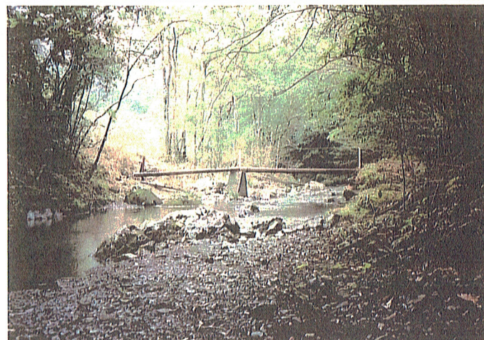
歩道(本橋)完成 (上流から) H15.3.24
