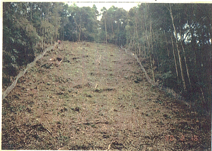
防護網の設置状況
