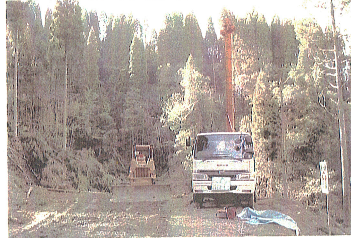
タワーヤード設置状況
