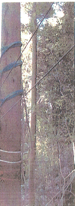
中間支柱(スナッチ)設置状況
