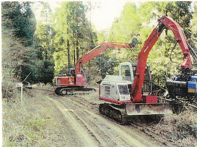
写真7 使用機械（奥スイングヤード、手前プロセッサ）
