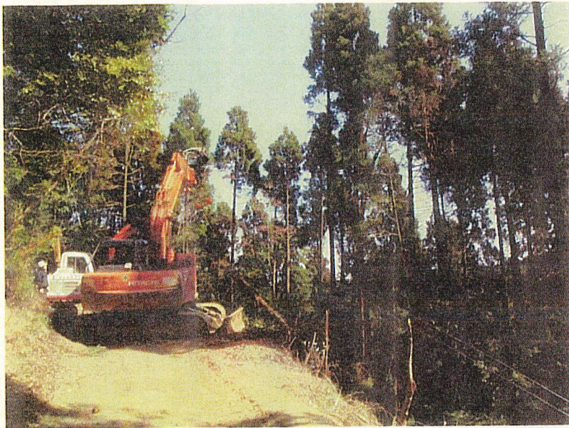
写真9 スイングヤードによる材の振り回し (プロット5)
