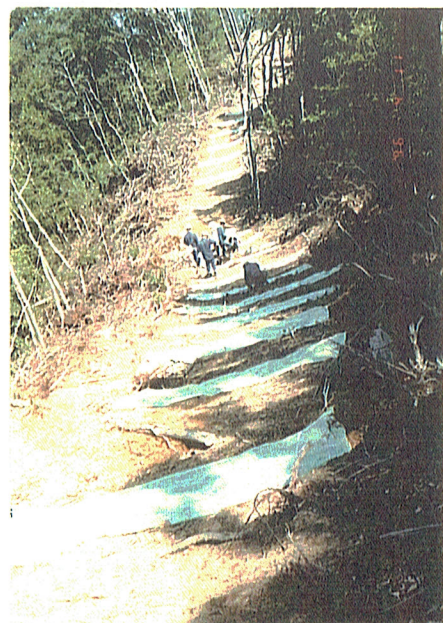
施工中 平坦部 2-3m間隔に張付
