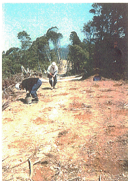
施工中 カシ類等の蒔種
