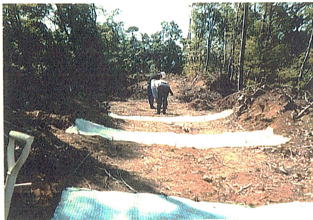
施工中 カシ類等の蒔種
