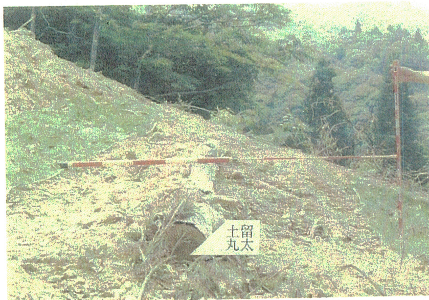
写真3 土留め丸太施工状況（平成8年度）
