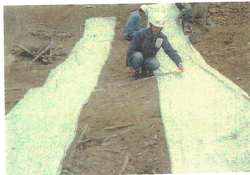
写真2 施工中状況（平成8年度）
