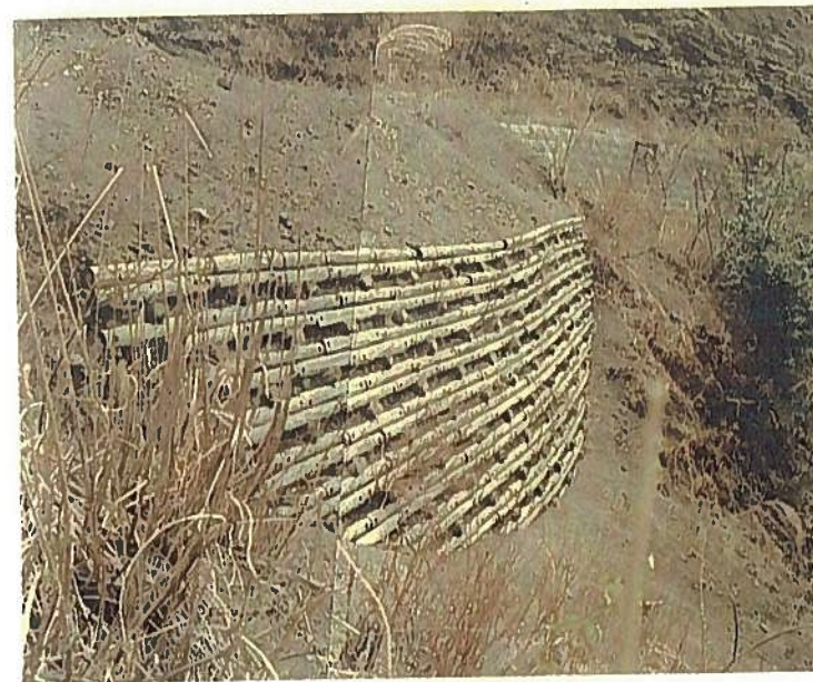
スギ 棧(防腐処理) 土羽下施工
