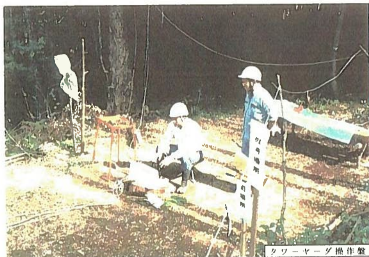
クローヤード操作盤
