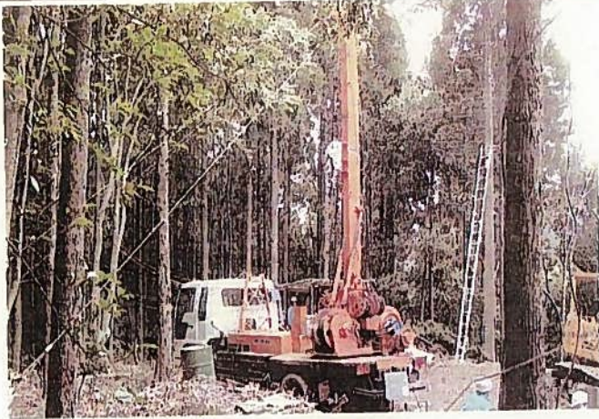
タワーヤーク設置状況
