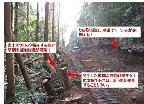
写真-2 作業路開設状況
