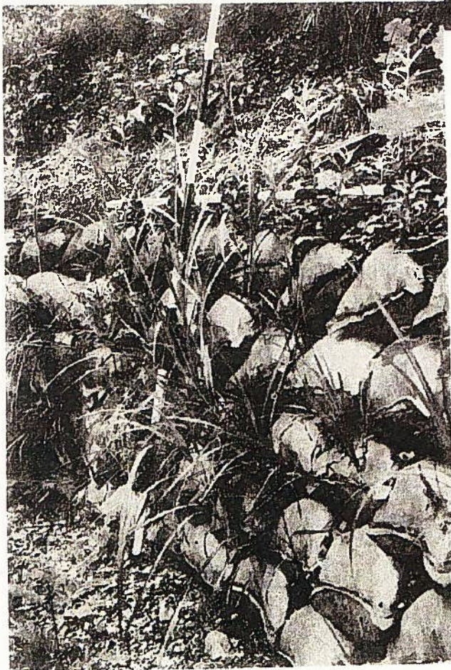
土のう土留エ
