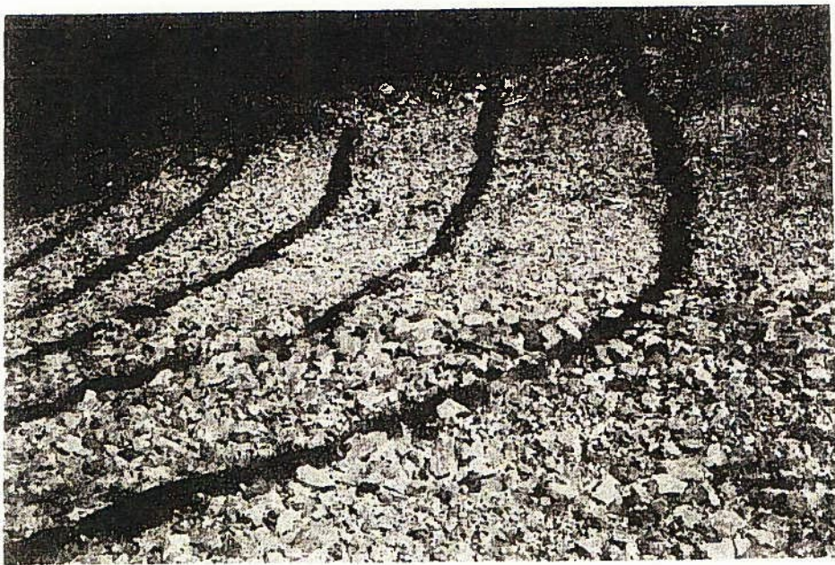
植生土のう筋工
