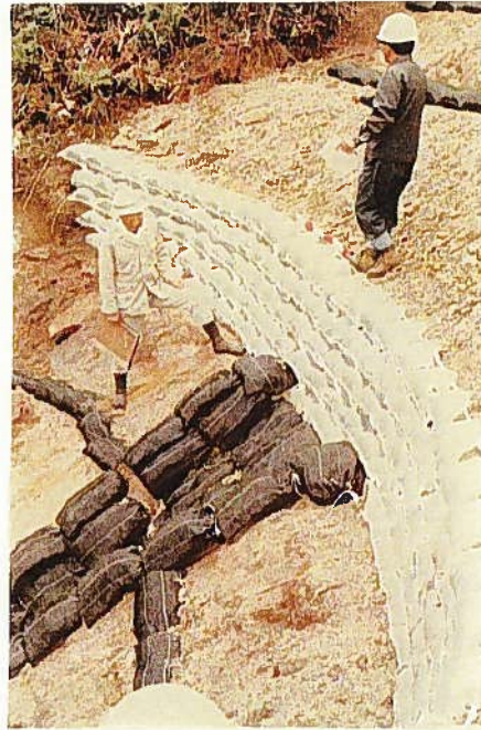
工の筋工及植生工の状況
