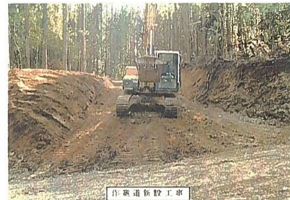
作業道新設工事
