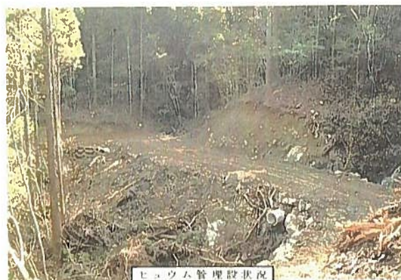
ヒュウム管理設状況
