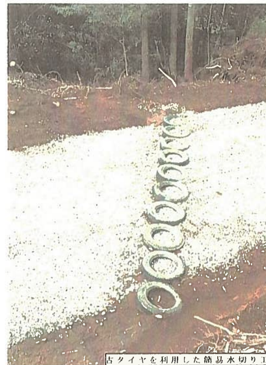
古タイヤを利用した簡易水切り工
