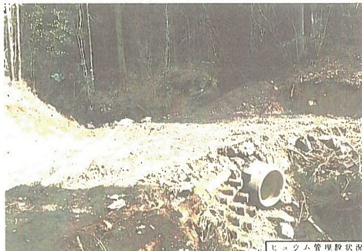
ヒュウム管理設状況
