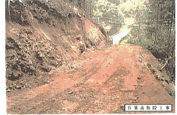
作業道新設工事
