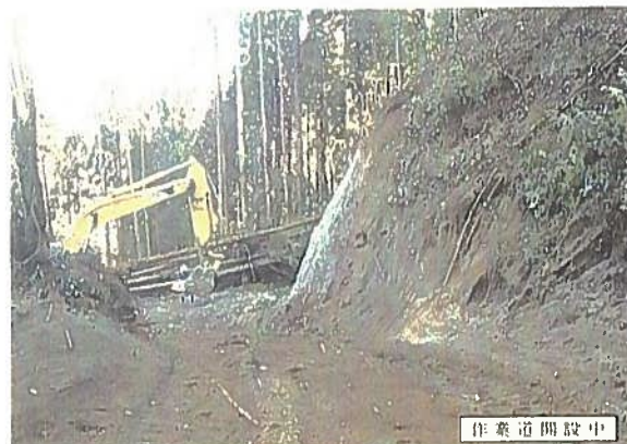
作業道開設中
