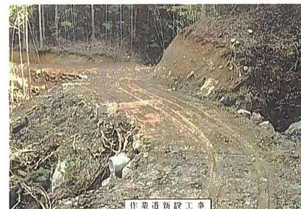
作業道新設工事
