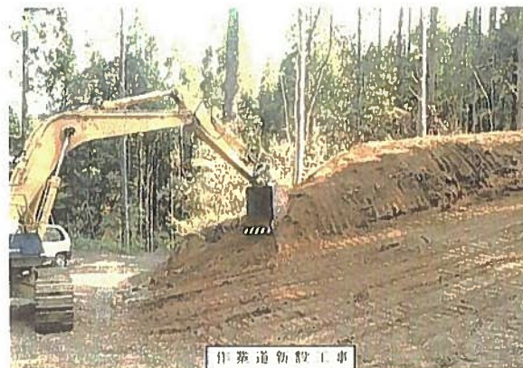
作業道新設工事
