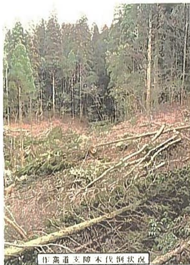
作業道と障害木伐倒状況
