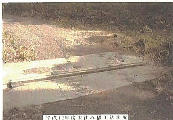
平成12年度末注み橋工法状況
