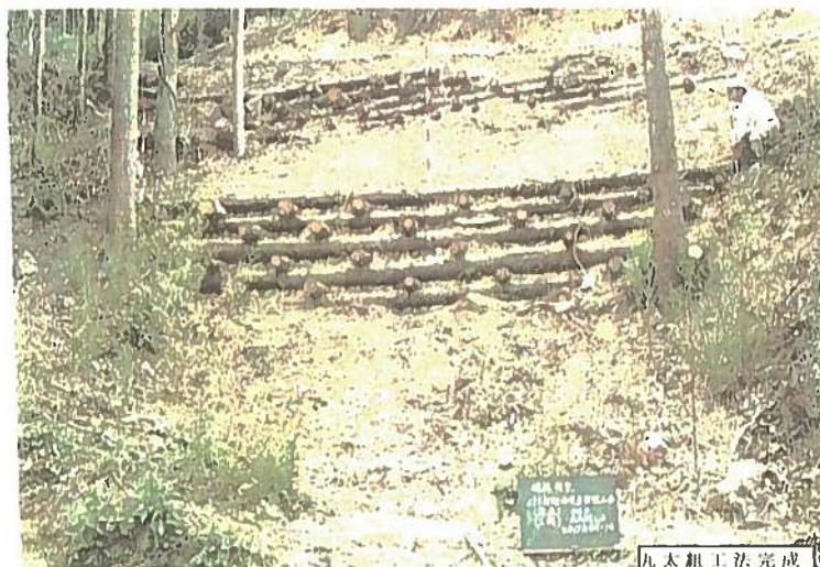
丸太組工法完成
