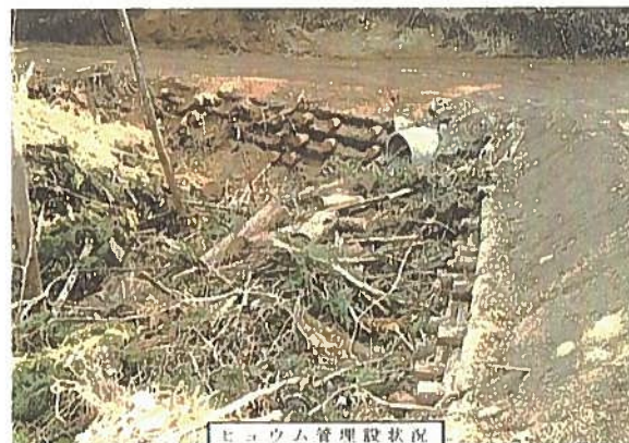
ヒュウム管理設状況
