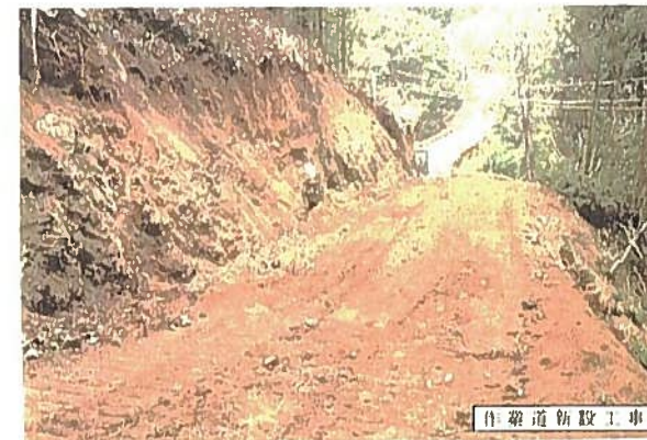
作業道新設工事
