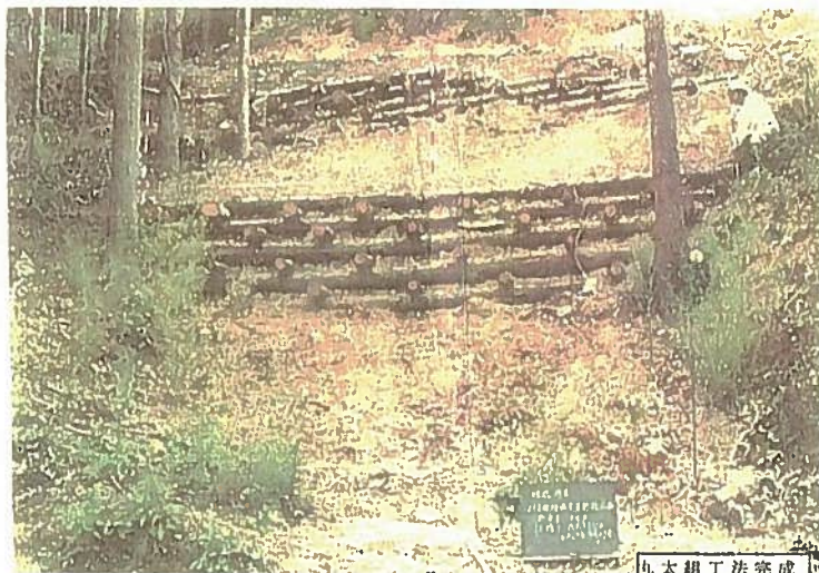
丸太組工法完成
