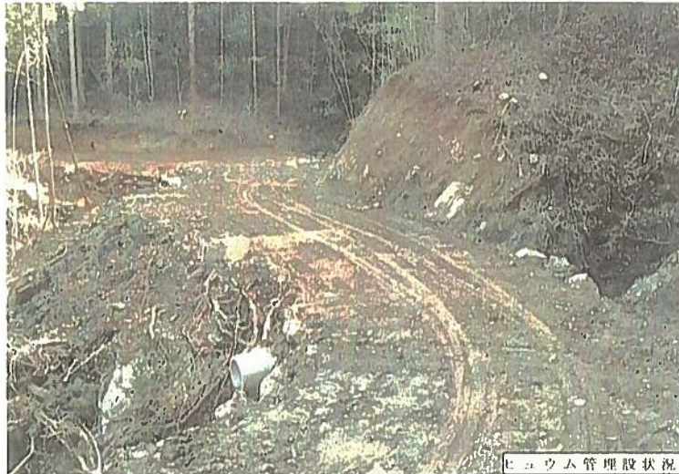
ヒュウム管理設状況
