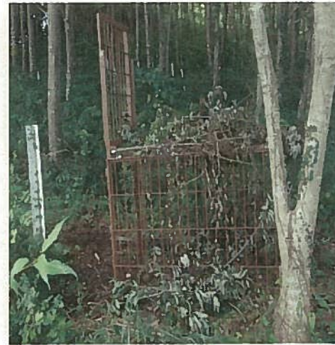
写真-14 鋼製箱罫設置状況
