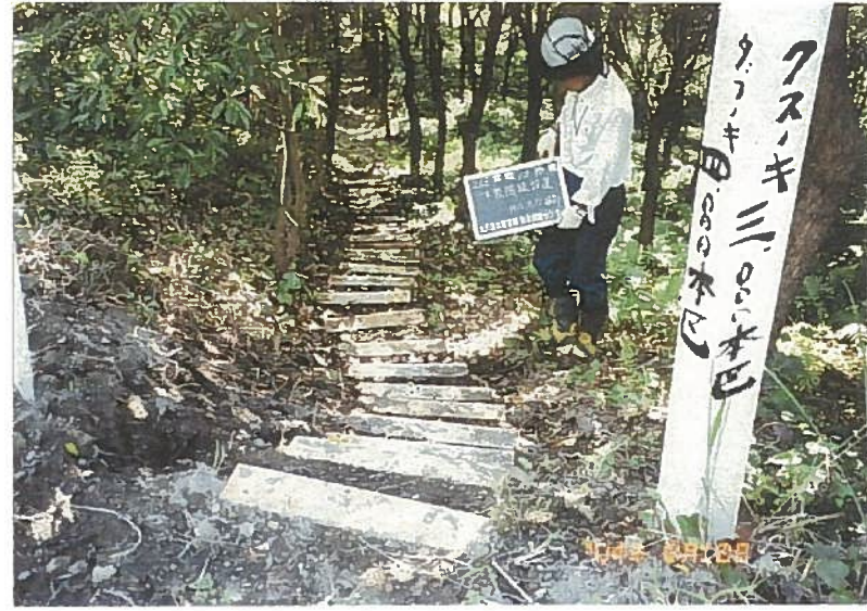
写真2 木製階段設置
