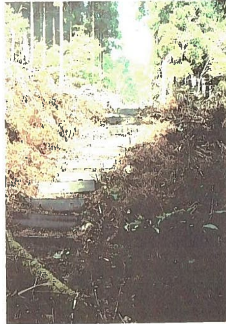
歩道入口表示と階段の設置状況 H16.3.27撮影
