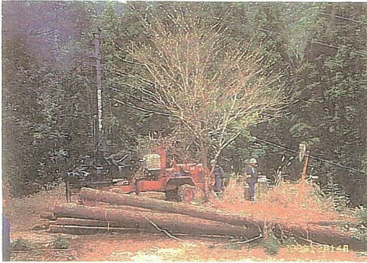
タワーヤード集材
