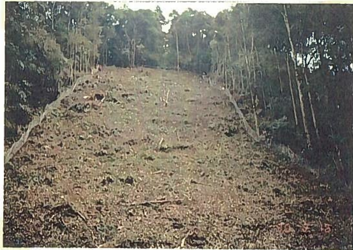
防護網の設置状況
