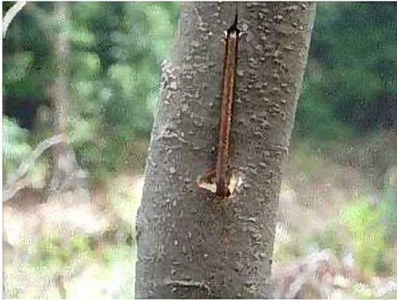
写真－ 12 (垂直)立木支柱かすがい止め 上段張りロープ切断状況
