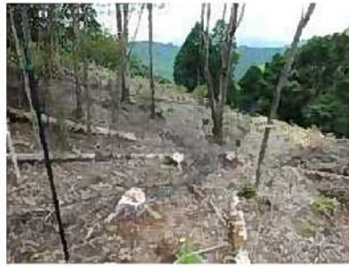
写真-27 立木支柱止め結束バンドによる補修
