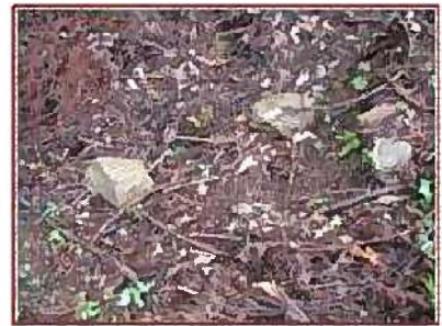
写真-22 石による補修
