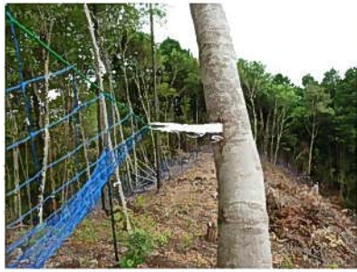
写真-26 立木支柱止め結束バンドによる補修
