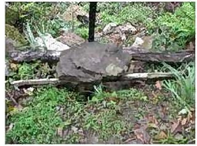
写真-28 シカ等侵入口丸太・石による補修
