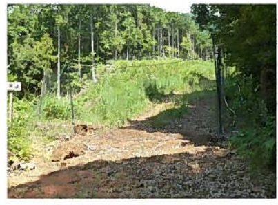
写真-25 西都昇湯土砂除去後
