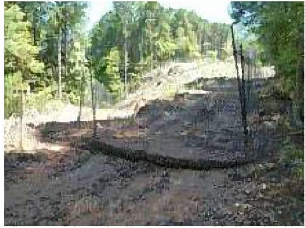
写真－9 枝条・土砂の堆積状況
