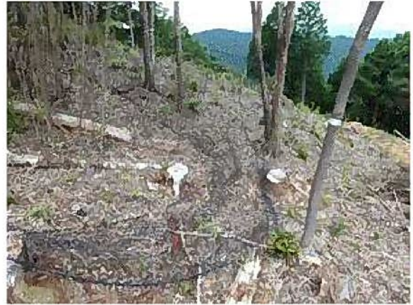
写真－ 13 (垂直)立木支柱ネット脱落状況
