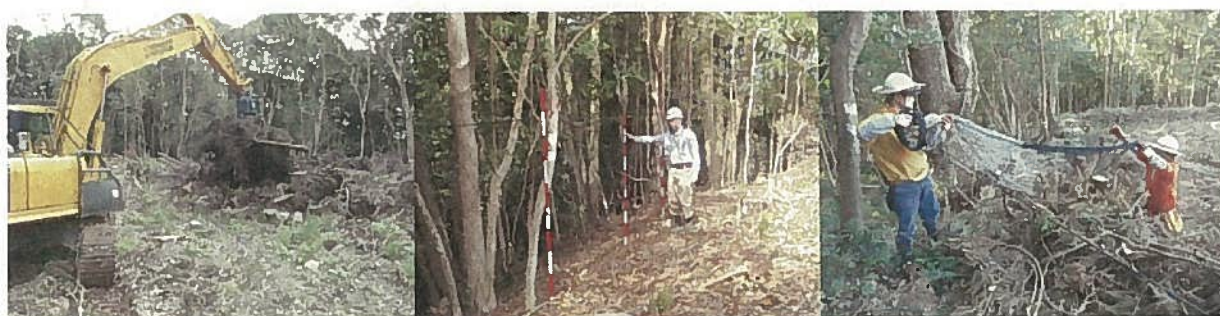
図-14 低コスト防鹿柵(左からロングリーチグラブによる枝条積、生立木ネット柵、枝条積+ネット柵)
