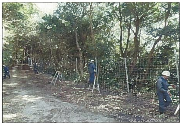
写真-2 シカウォール設置状況 (平成 22 年度)
