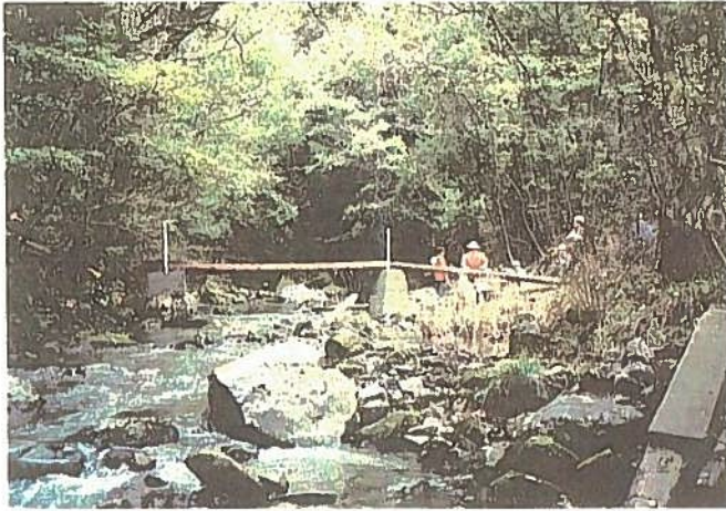
木橋作設中 (下流部付近) 1/15.3.24
