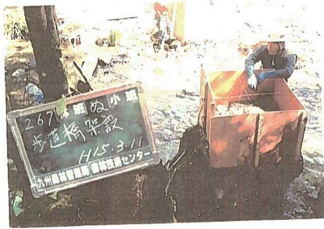
H15.3.11 歩道橋脚部製作中
