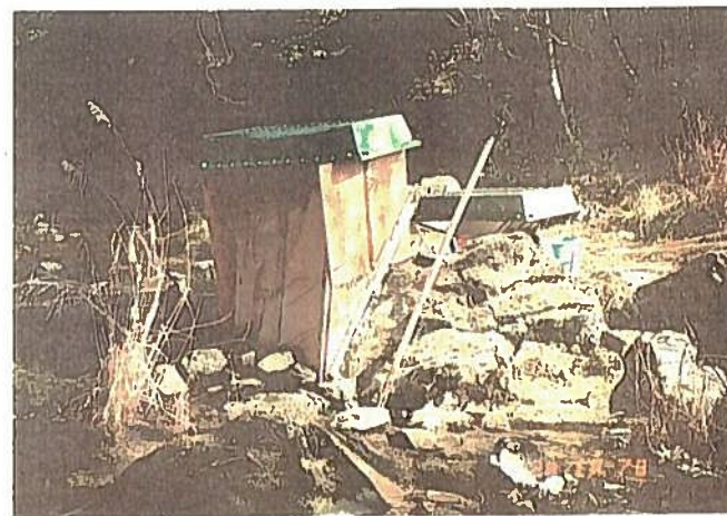
橋脚部の製作状況 H15.3.12
