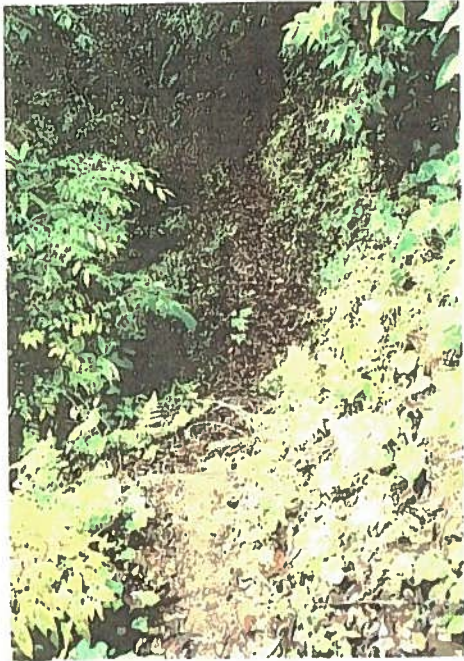
歩道整備前 11/15 5/14 撮影
