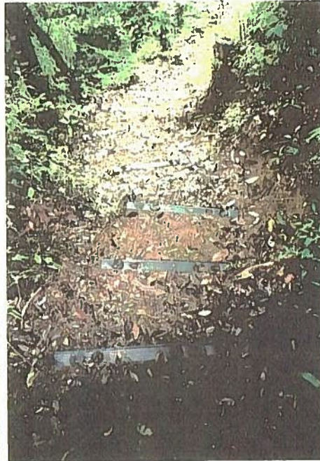
歩道整備後 11/15 6/12 撮影
