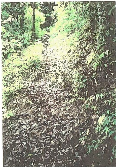
歩道整備前 H15 5/14 撮影
