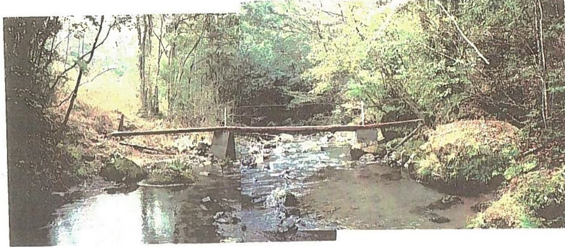
歩道(木橋)完成 和石川上流部から撮影 H15.3.24
