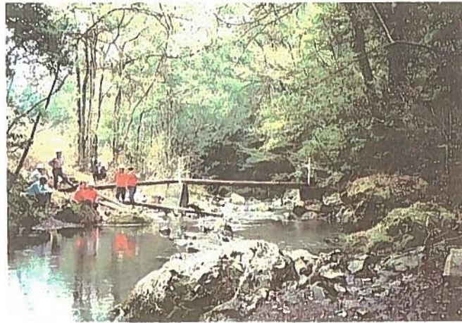
木橋作設中 (上流部付近)
