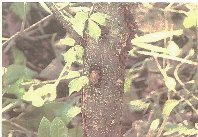
写真4 カミキリムシ被害状況
