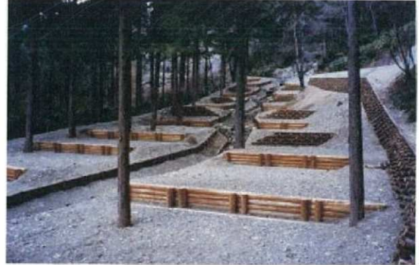
木柵工、木製水路工
