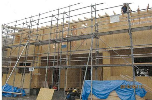
建設中の2×4住宅
