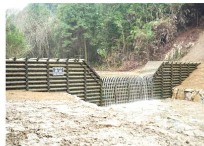
間伐材を使用した床固工（五島市）
