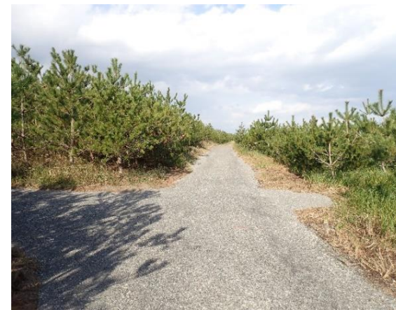
管理用作業道新設の状況
