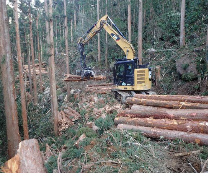
【森林整備（保育間伐〔活用型〕）の造材状況】
