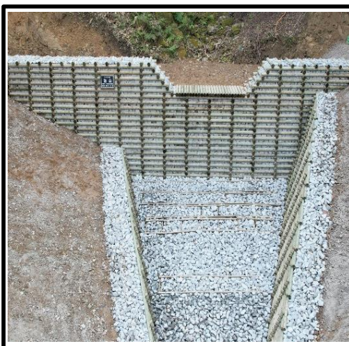
木材を使った治山ダムの設置
