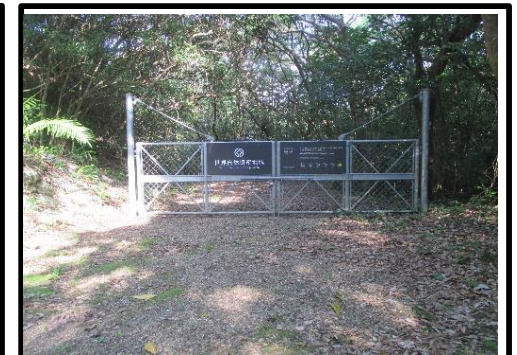
剥岳林道入口ゲート(徳之島)
