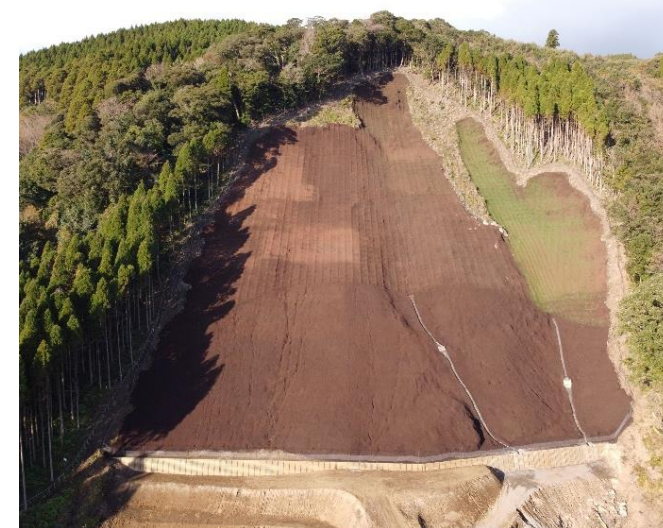
山腹崩壊箇所の復旧
