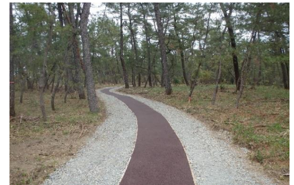
海岸保安林作業道整備
