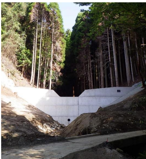
上轟治山工事(溪間工) (久山町)
