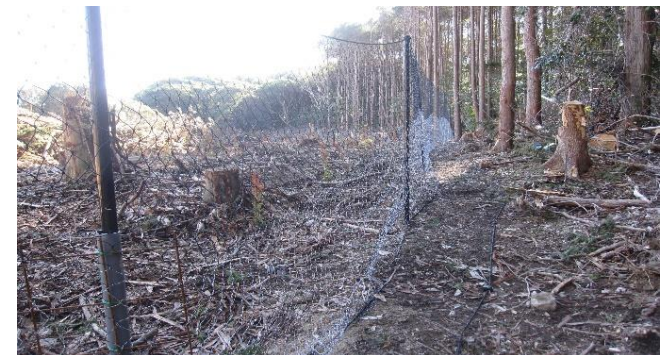
防護柵設置後
