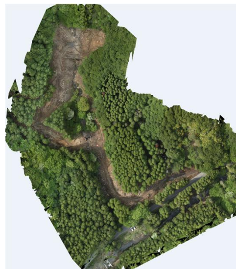
3次元起工測量
