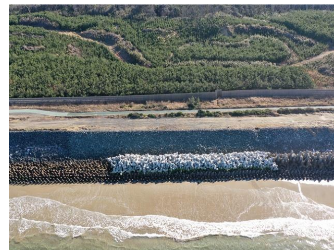
治消波ブロック工事
