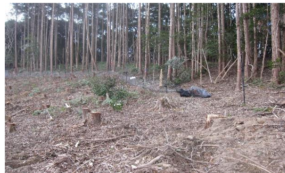
防護柵設置中
