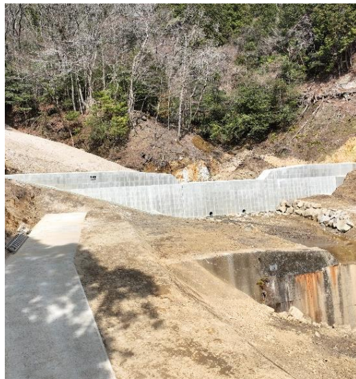
内浦治山工事(溪間工) (東峰村)
