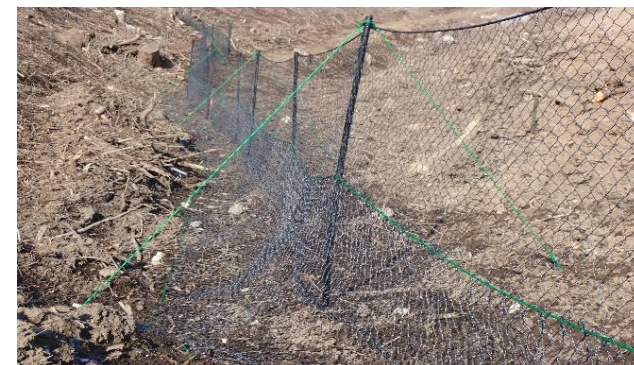
ネットの違いによる設置コスト、効率性の比較・検証（野上平家山国有林：九重町ほか）
