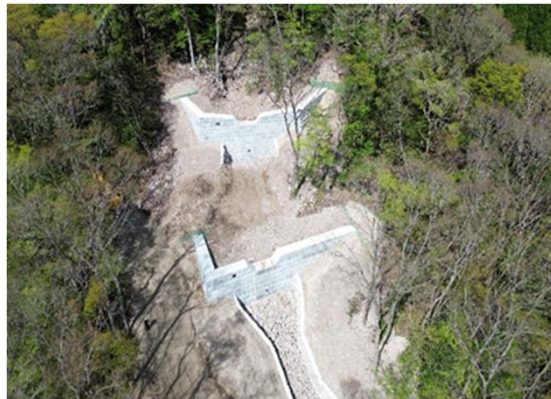
施工後の状況
