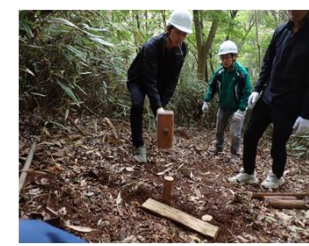
遊歩道作設の様子
