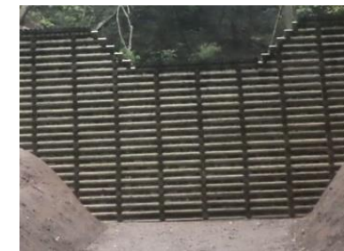
木製谷止工による施工状況 (宇土市 西木原国有林)
