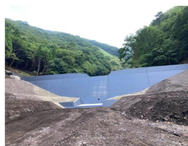
景観に配慮した谷止工の施工状況 (小国町 源太園国有林)
