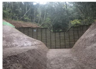
木製谷止工による施工状況 (宇土市 西木原国有林)
