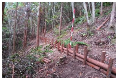
流域保全総合治山事業による 本数調整伐及び筋工の状況 (湯前町 湯前国有林)
