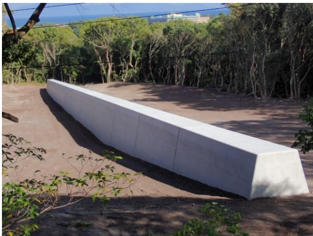
溪間工（島原市：安中4溪）
