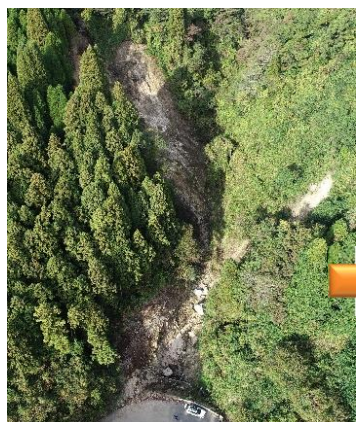
山腹斜面の崩壊状況
