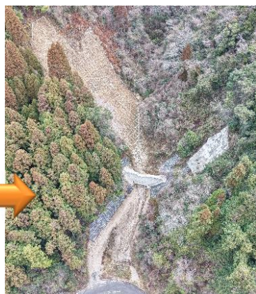
山腹工、溪間工の完成状況
