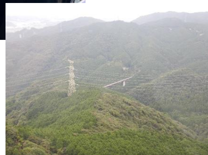
ヘリコプターによる被害状況調査
