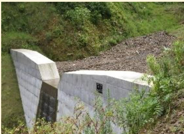
治山ダムの設置による河川区域への砂・流木の流出を抑制
