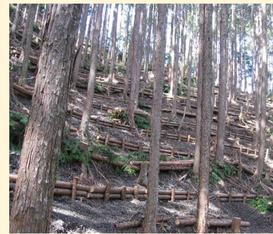
保安林整備と筋工の設置による土壌の保全
