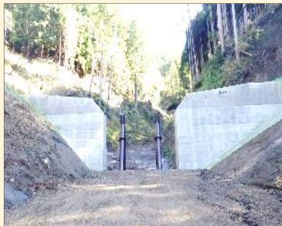
流木捕捉式治山ダムの設置
