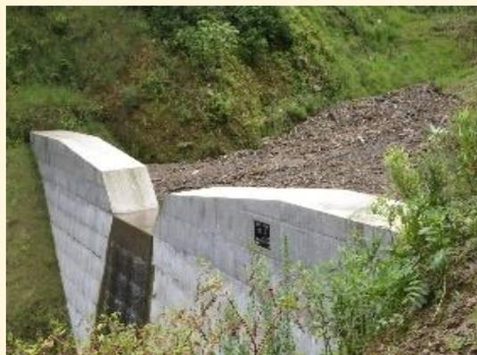
治山ダムの設置による河川区域への土砂・流木の流出を抑制
