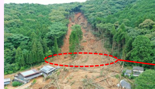
林地被害の状況(芦北町)
