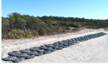
護岸工による林帯の浸食防止 (いちき串木野市)
