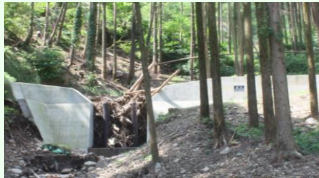
谷止工による流木捕捉 (志布志市)
