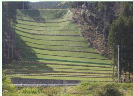
崩壊斜面の復旧状況(朝倉市)
