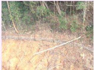
上空からのシカ防護ネットの確認
