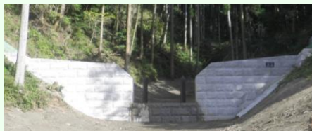
荒廃溪流の復旧状況(朝倉市)
