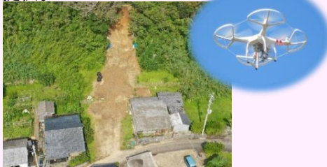
ドローンで撮影した被害状況の写真
