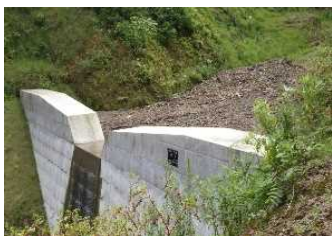
治山ダムの設置による河川区域への土砂・流木の流出を抑制
