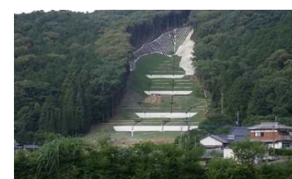
集落上部において治山事業による復旧工事が完成。(熊本県芦北町)
