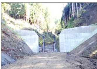
流木捕捉式治山ダムの設置
