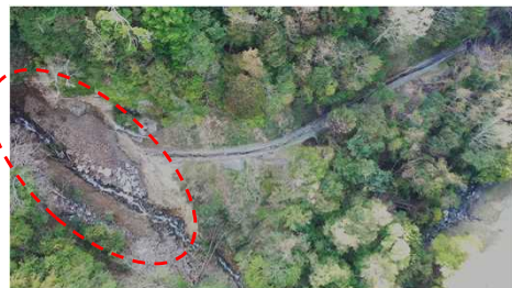
ドローンにより確認した林道の決壊状況
