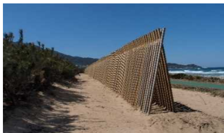
防風柵による松林の保護(福岡県岡垣町)
