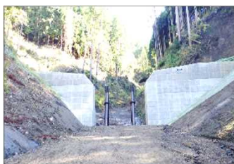
流木捕捉式治山ダムの設置
