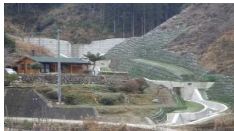
治山事業による復旧工事が完成。住民が新たに住宅(左側)を再建し帰還。(福岡県朝倉市)
