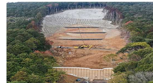
治山事業と砂防事業が連携して林地崩壊等の復旧工事(写真は治山事業)を実施。(熊本県津奈木町)
