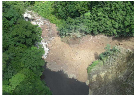
(土砂ダムの状況)
